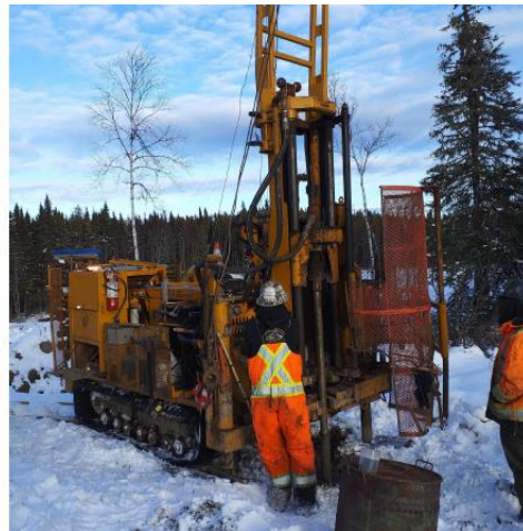
Photos de forage géotechnique
